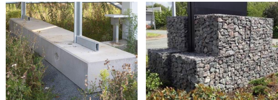
Semelles en béton (à gauche) et gabions (à droite)
