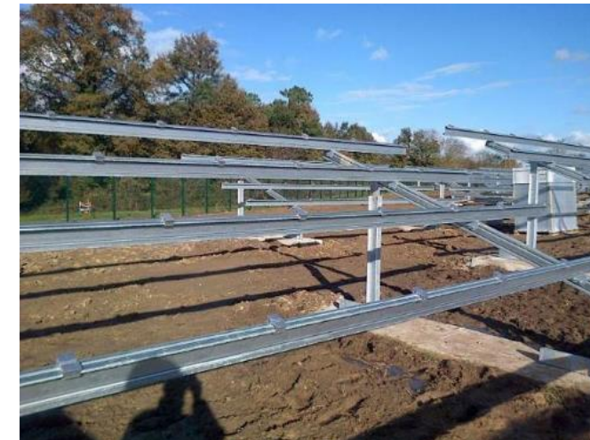
Figure 50 : Exemple de chantier de construction – Pose des structures (Source : (Crédit photo : SERGIES, 2015))
